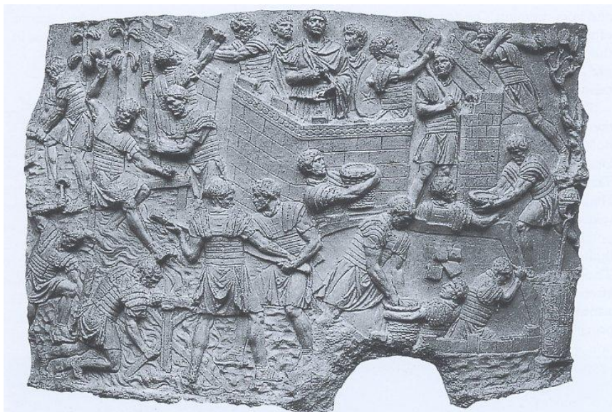
Relieve de la columna de Trajano. Escena XX con soldados trabajando en la construcción de una muralla
