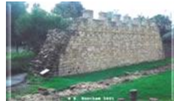
Pared reconstruida junto a la original
